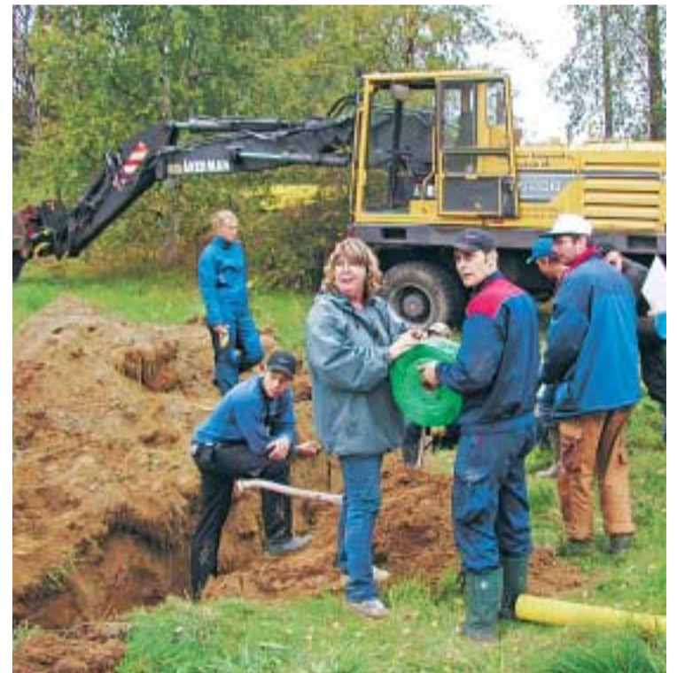
■ Hur ska vi nu lägga rören? Här planeras det i byn Kattisavan.
