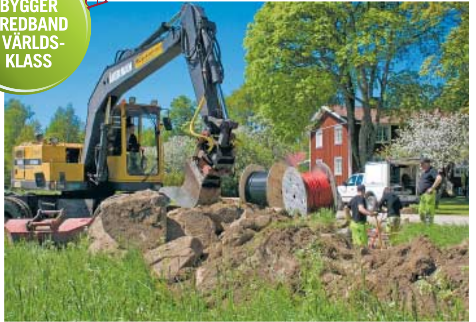
■ Att gräva för bredband är inte alltid så lätt i Småland. Överallt finns dessa stora stenblock som måste röjas undan för att fiberkabeln ska nå in till byarna.
